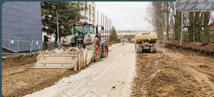
Sanace podkladních vrstev komunikace, Ruzyně
