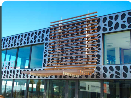
Designová fasáda z nerezových výpalků kancelářské budovy EXBIO
