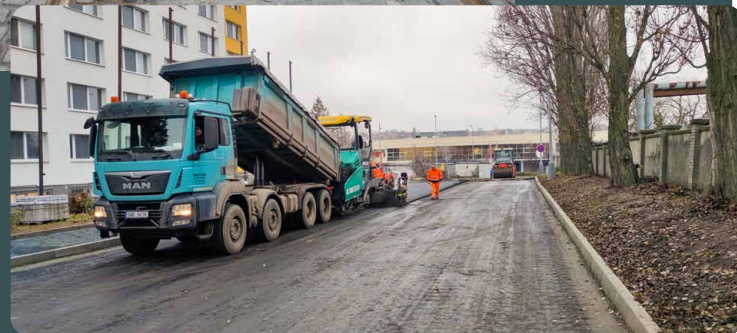
Položené asfaltové souvrství areálu VUSS Ruzyně
