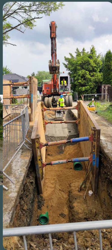
Výstavba splaškové a dešťové kanalizace, Strančice
