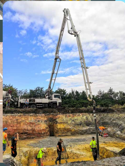
Výstavba bezpečnostního přepadu, vodojem Bášť
