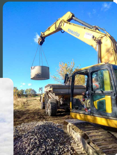
Výstavba bezpečnostního přepadu, vodojem Bášť
