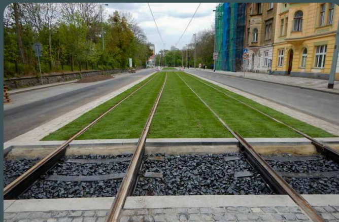
Zrekonstruovaná tramvajová trať Sokolovská, Invalidovna
