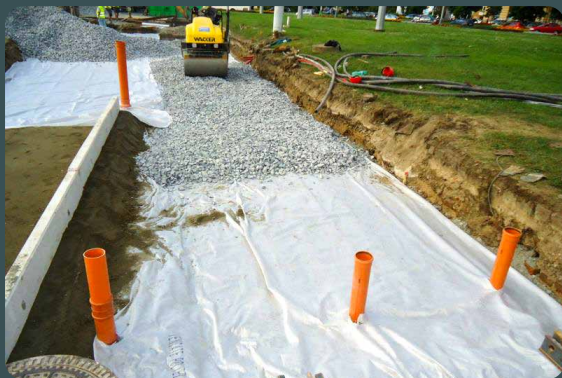
Realizace konstrukčních skladeb tramvajové trati, Vítězné náměstí
