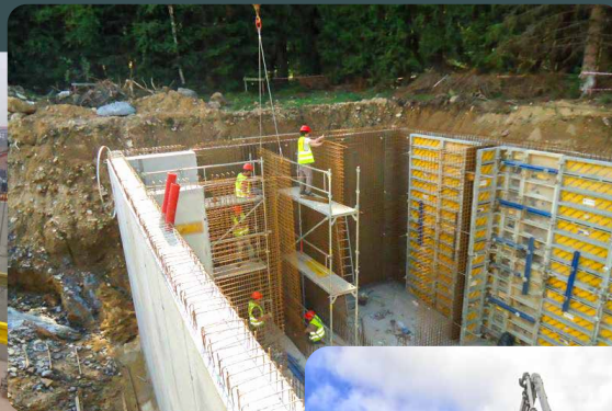
Monolitická nádrž, ČOV Prácheň
