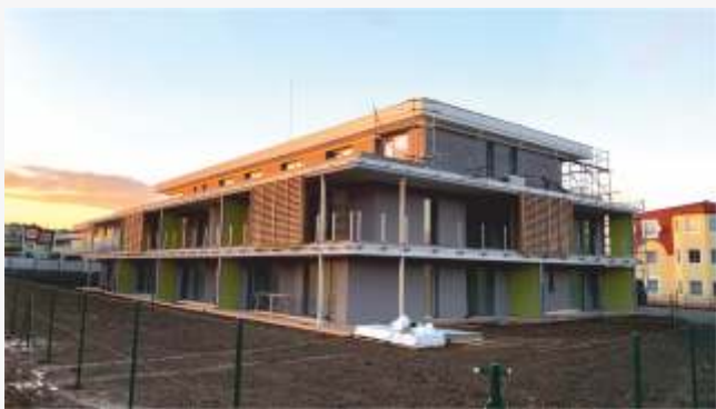
výstavba bytového domu Vestecké Terasy
